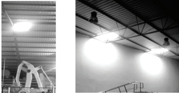
Figura 7: Instalação de claraboias – Armazéns e linhas de engarrafamento
