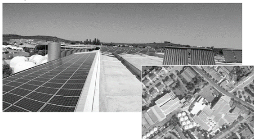
Figura 8: Sistema fotovoltaico instalado – Cobertura Adega de Borba
