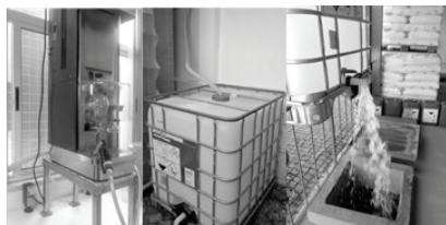
Figura 3: Recuperação de água de arrefecimento do condensador do destilador – Laboratório
